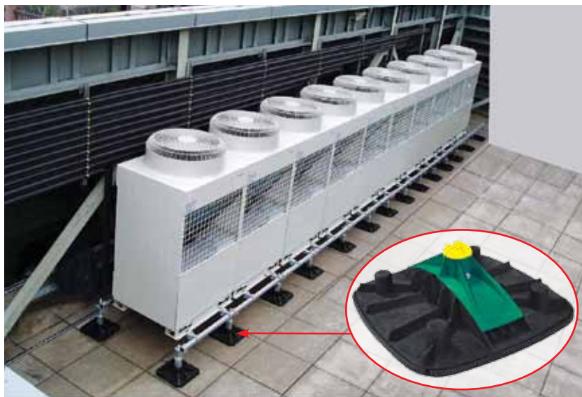
Рис. 7. Конструкция опор для установки тяжелого оборудования
